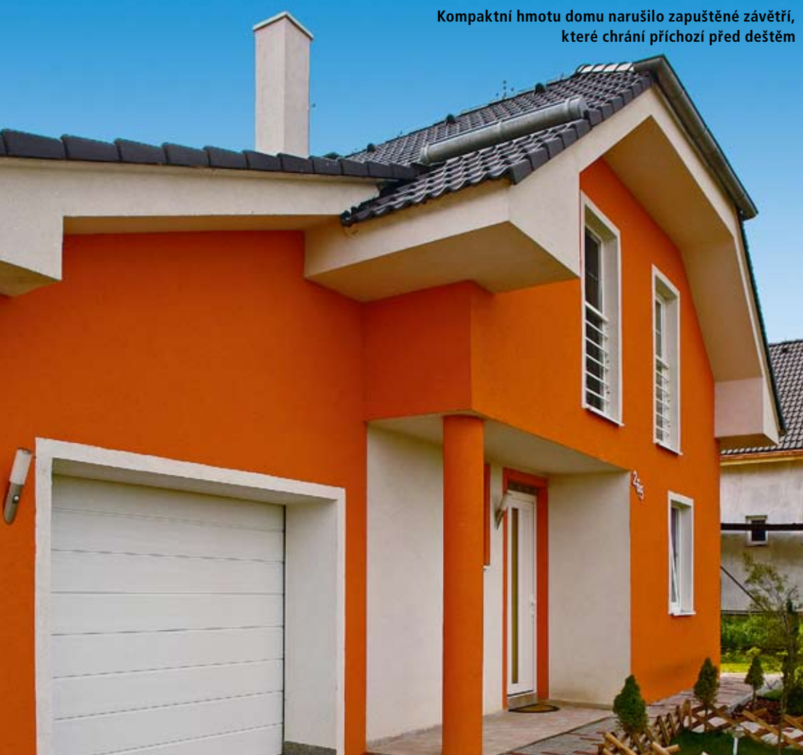
Pohled ze zahrady. Tradiční dřevěné podbití střechy nahradil vlhku odolný sádkokarton, čímž se zjednodušila údržba fasády. Okna lemovaná bílými šambránami dodávají stavbě tradiční ráz
